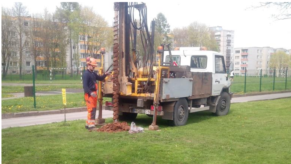
1 pav. Lauko darbai
